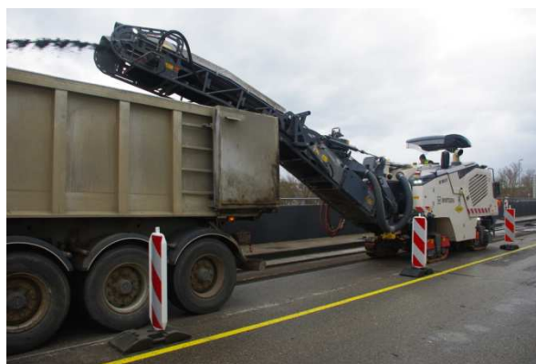
La première couche d'enrobés a déjà été enlevée
